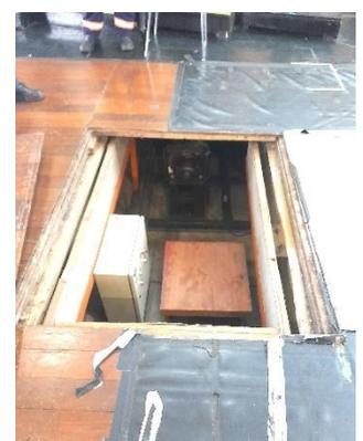
A remoção dos alçapões para manutenção é um processo relativamente rápido. Durante uma inspeção realizada o alçapão número 4 não foi retirado, pois poderia resultar na necessidade de remover o tapete para acesso, evitando assim precisar rasgá-lo. Contudo, é importante que o tapete nesse local seja removível da mesma forma que os tapetes nos outros alçapões, usando uma fita para fixá-lo novamente ao fim dos serviços.
