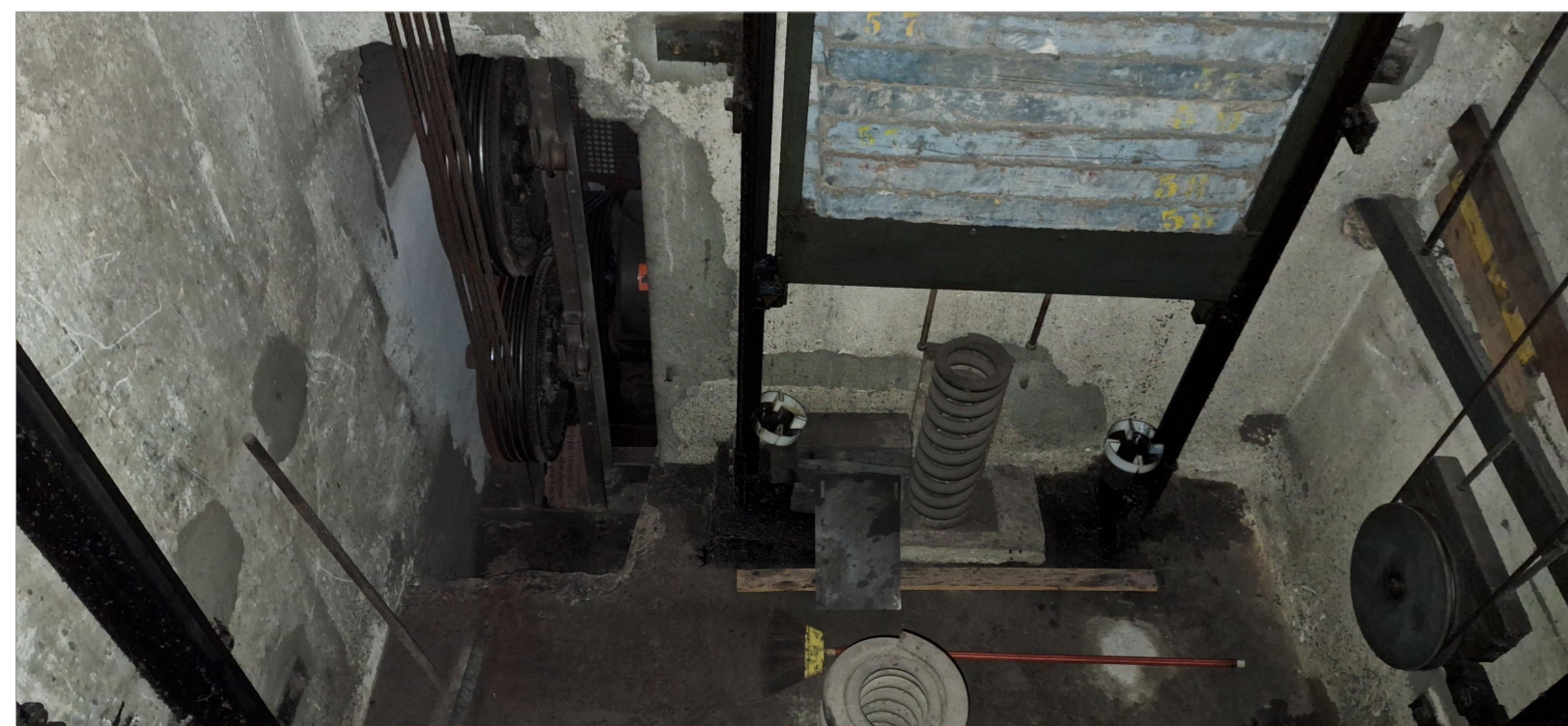
FOTO DO POÇO DO ELEVADOR
