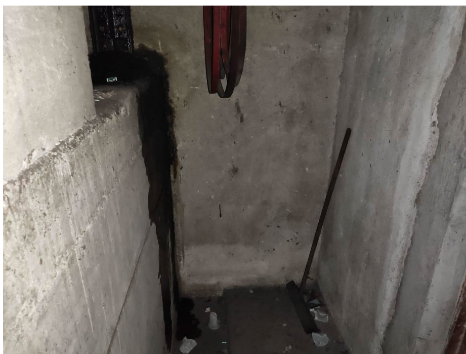
Figura 2 e 3 - Bloco de concreto acima do piso
