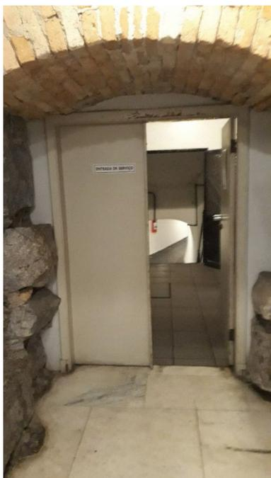
*Figura 6 - Porta dupla de madeira a ser substituída pela PCFT9, com pintura da mesma cor do existente*
