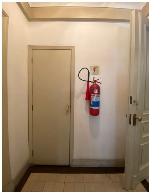
*Figura 7 – Porta em madeira a retirar para instalação da PCF23, com pintura da mesma cor do existente*
