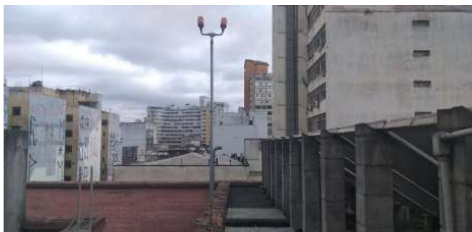
Foto: Baliza lado da caixa de água
