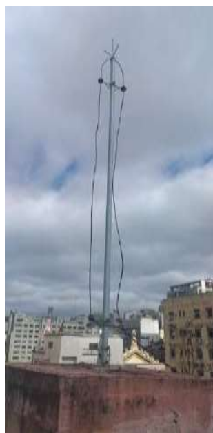
Foto: Cabo de descida desconectado
