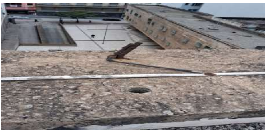
Foto: Conexão soldada ao vergalhão de descida
