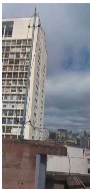
Foto: Cabo de descida desconectado
