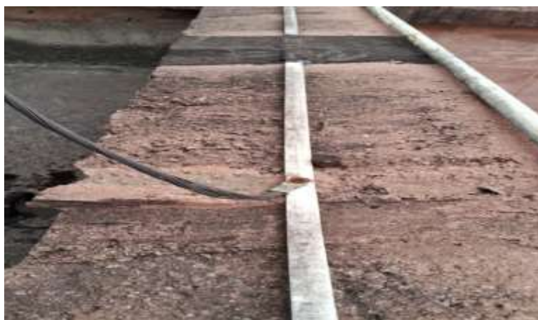
Foto: Anel superior em barra de alumínio
