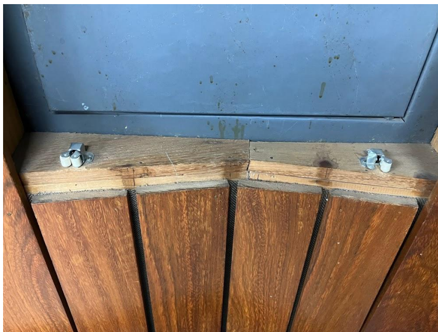
3. Porta de madeira da varanda do 5º pavimento com batedor danificado.
