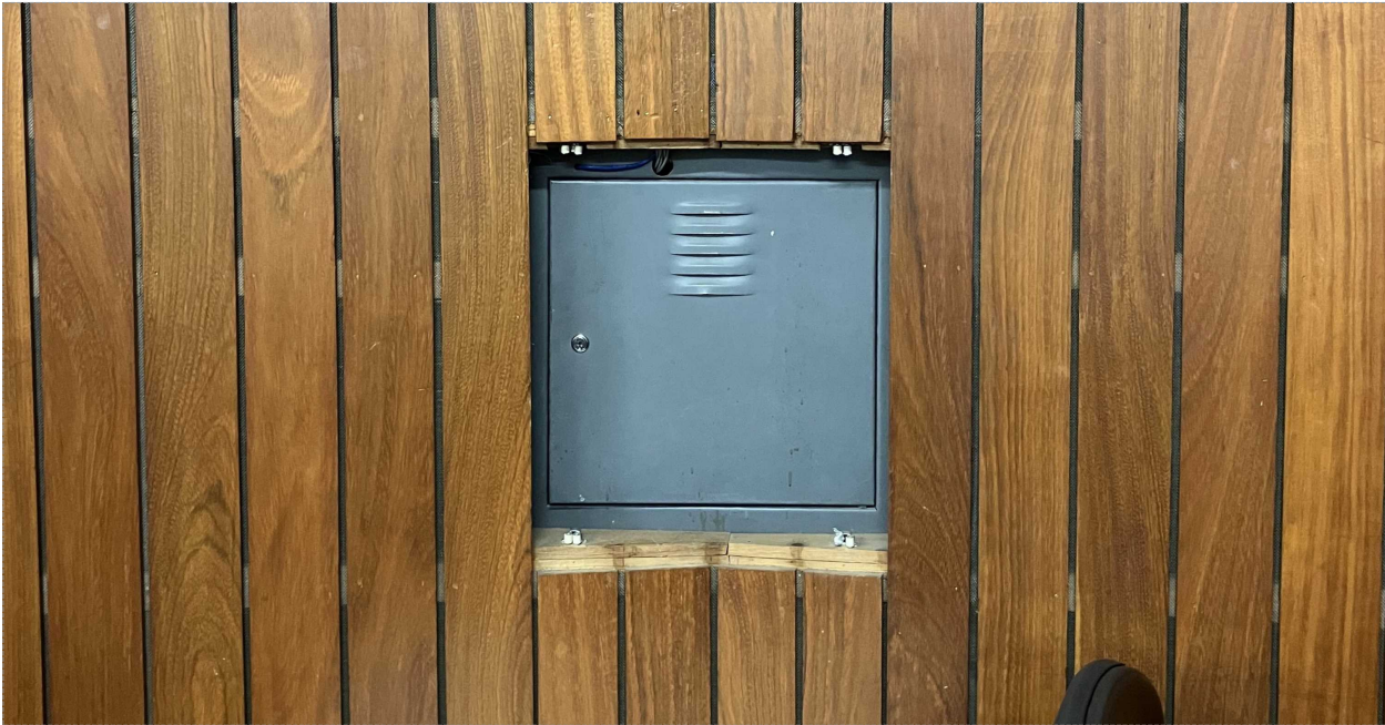
FOTO DO PAINEL ONDE A PORTA SERÁ INSTALADA
