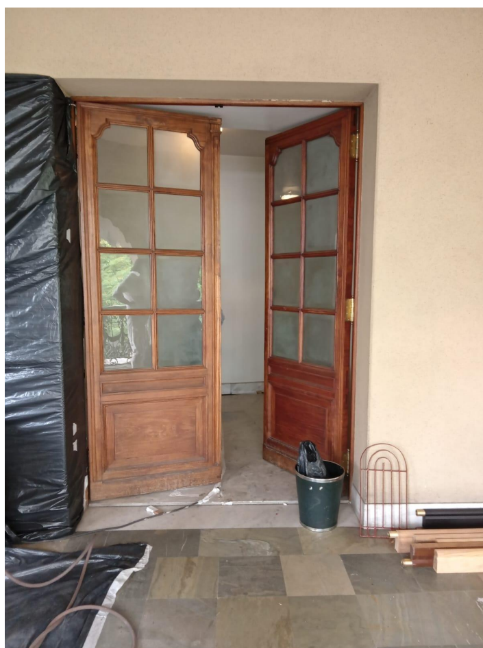
3. Porta de madeira da varanda do 5º pavimento com batedor danificado.
