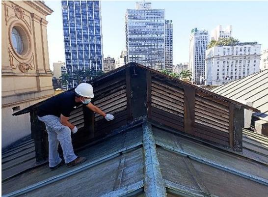
A inserção de novas partes será com recorte semelhante, mantendo encaixe entre as partes, recortes de sambladuras e se necessário, onde forem peças largas, usar cavilhas com adesivo PVA.
