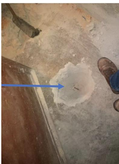
*Imagens 06 - Perfuração 03 no centro da caixa. Destaque para a estaca que alcançou 1,25m de profundidade até encontrar solo firme.*
