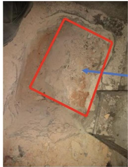
*Imagens 03 e 04 - Perfuração 02. Foi encontrada parte das fundações estruturais do TMSP neste ponto de prospecção - Destaque em vermelho.*
