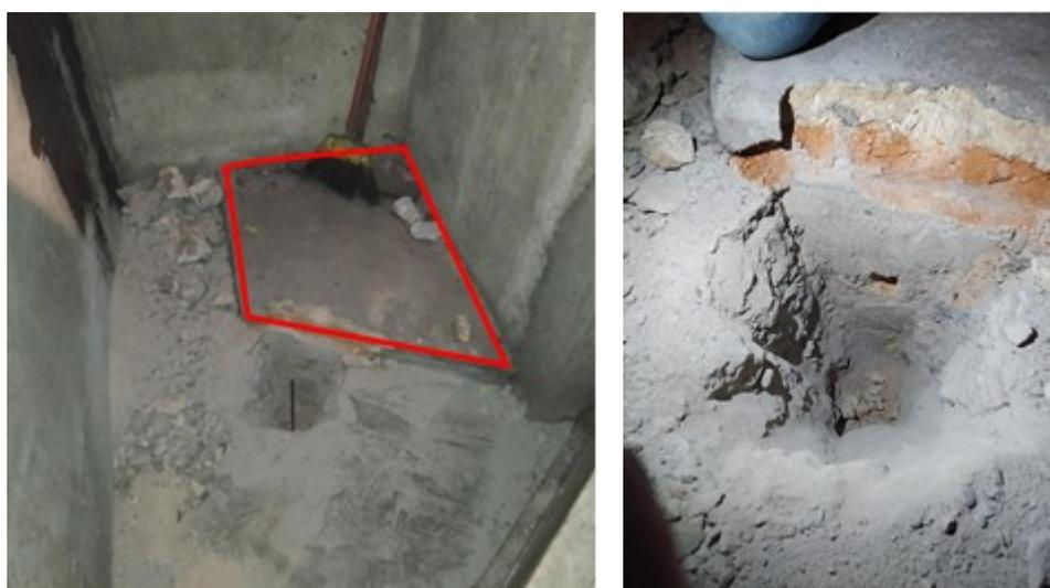
*Imagens 01 e 02 - Fotografias da perfuração 01. Escavou-se a uma profundidade de 1,30m a partir do nível do piso do Salão dos Arcos. Destaque em vermelho para parte do bloco de fundação estrutural do TMSP.*
