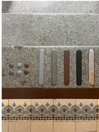
A partir dos testes feitos no local, percebe-se que a sinalização tátil posicionada sobre a faixa ornamentada do ladrilho hidráulico não apresenta leitura clara. Quando posicionado sobre o piso de granito, a peça em cinza claro apresenta contraste suficiente e uma presença discreta.
