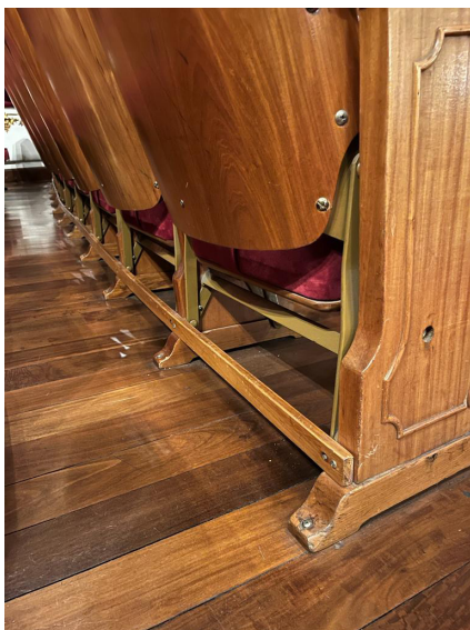
travessa de estruturação dos assentos
