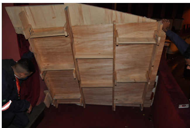
vista da estrutura do tablado existente
