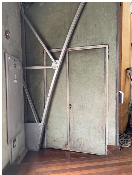
Figura 11 - Porta metálica a retirar para instalação da PCF82
