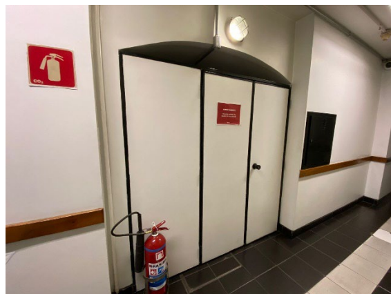
Figura 3 - Divisória e porta a retirar - tanque de óleo – para instalação da PCFT14
