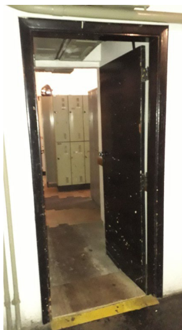
Figura 5 - Porta de metálica a ser retirada para instalação da PCFT18, com mesmo padrão de acabamento
