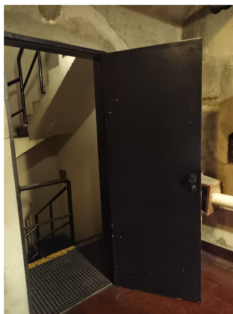
Figura 9 - Porta metálica a retirar para instalação da PCF71
