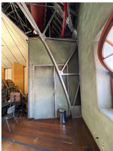
Figura 12 - Porta metálica a retirar para instalação da PCF83
