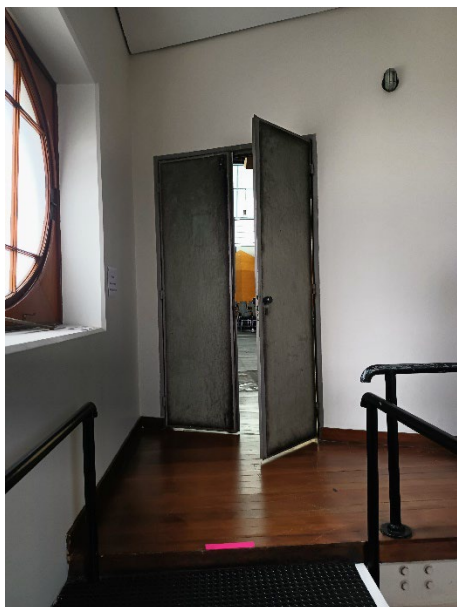
Figura 10 - Porta metálica a retirar para instalação da PCF81
