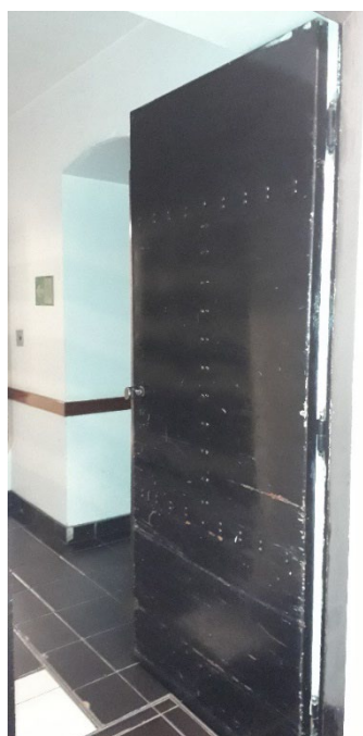
Figura 4 - Porta metálica a ser retirada para instalação da PCFT11, com mesmo padrão de acabamento
