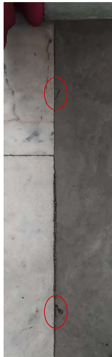
ÁREA 02 M_AN_06 - FOTO SITUAÇÃO
