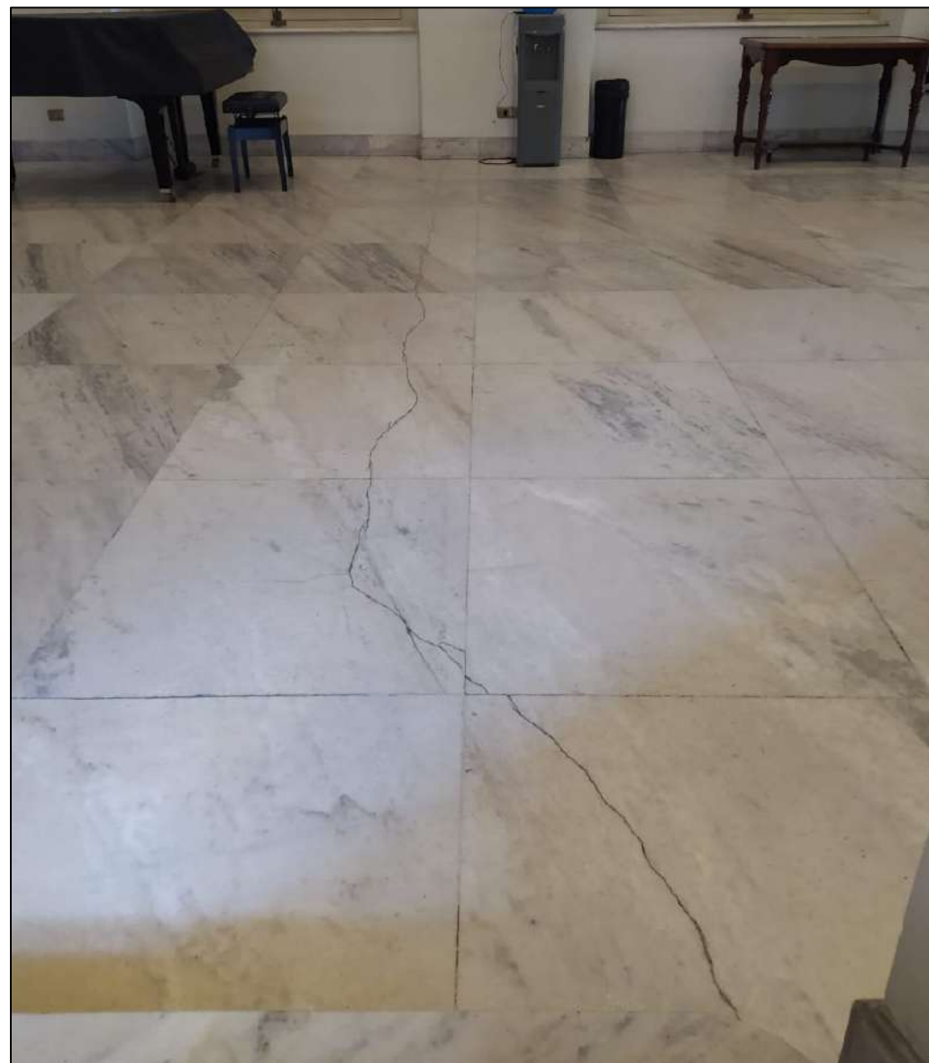
ÁREA 02 M_AN_05 - FOTO SITUAÇÃO
