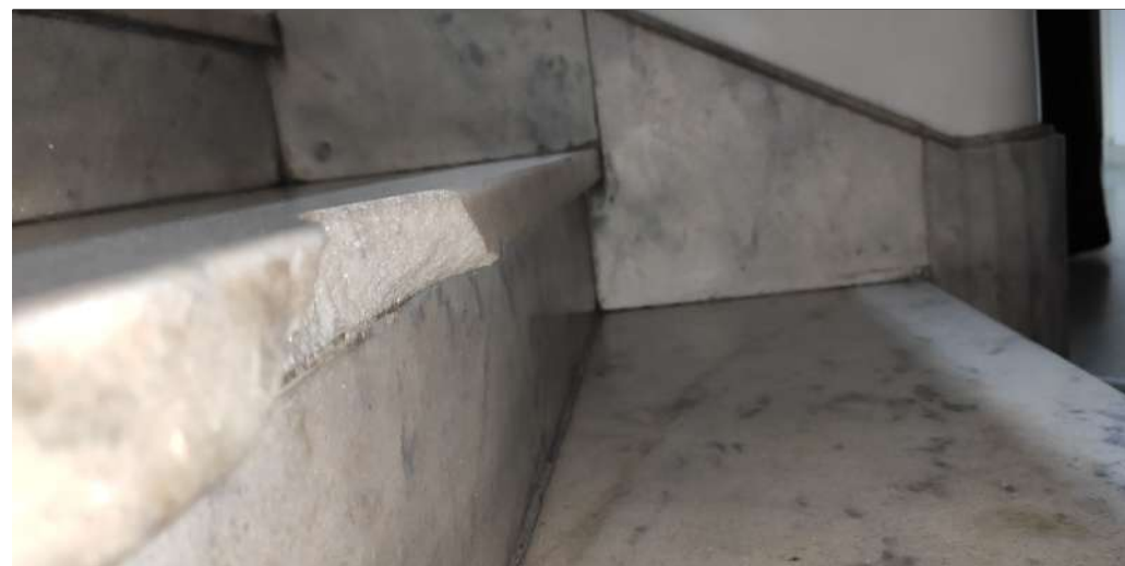
ÁREA 02 M_AN_04 - FOTO SITUAÇÃO
