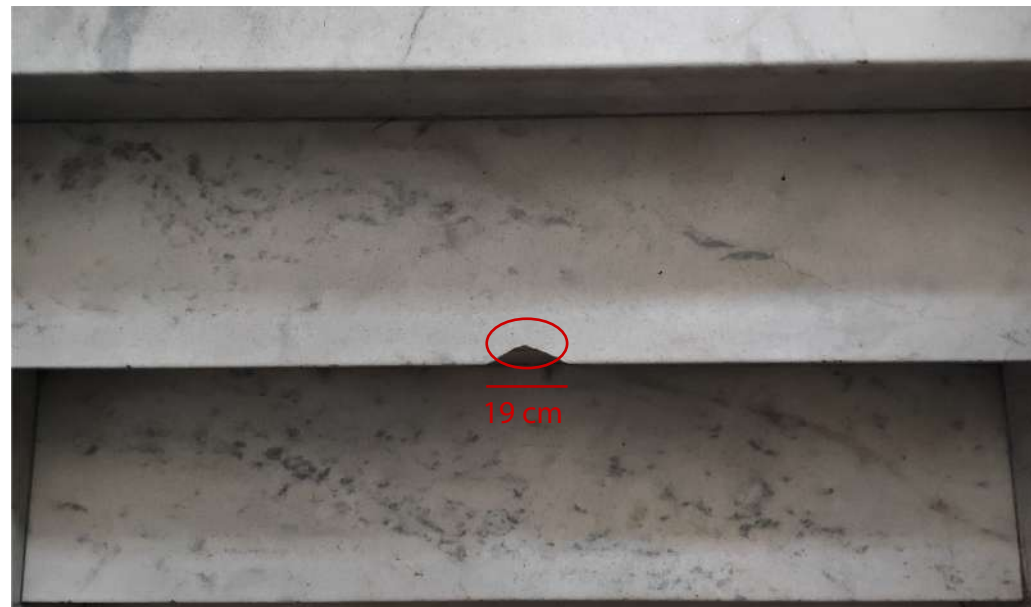
ÁREA 02 M_AN_04 - FOTO SITUAÇÃO
