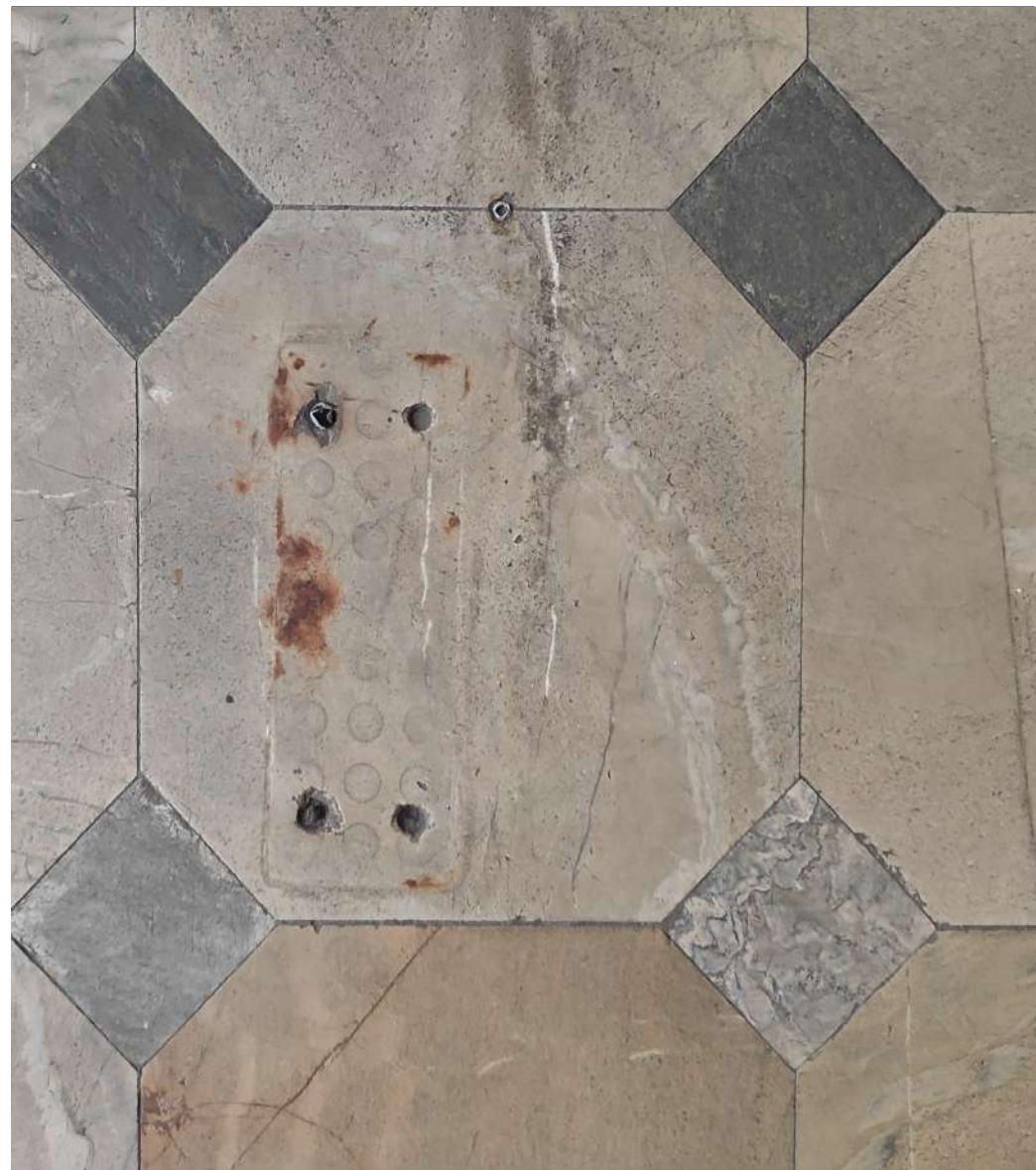
ÁREA 01: M_AN_03 - FOTO SITUAÇÃO
