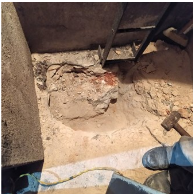
Imagens 03 e 04 - Perfuração 02. Foi encontrada parte das fundações estruturais do TMSP neste ponto de prospecção - Destaque em vermelho.
