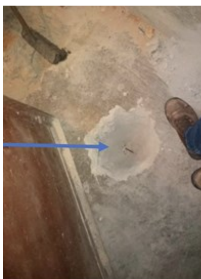
Imagens 05 - Perfuração 03 no centro da caixa. Destaque para a estaca que alcançou 1,25m de profundidade até encontrar solo firme.
