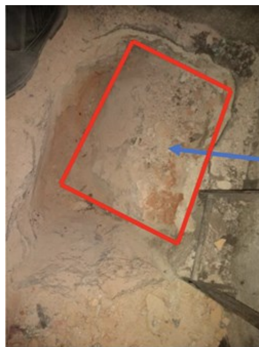
Imagens 03 e 04 - Perfuração 02. Foi encontrada parte das fundações estruturais do TMSP neste ponto de prospecção - Destaque em vermelho.
