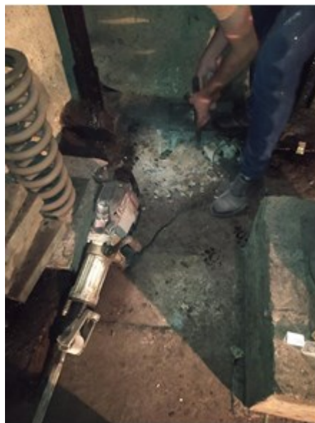
Imagem 06 - Perfuração 04. Furação feita na caixa de concreto onde estão as molas de segurança do elevador existente.
