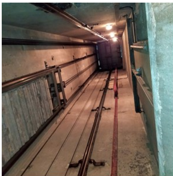
Imagem 07 - Fotografia da caixa do elevador atual a partir do nível do Salão dos Arcos.
