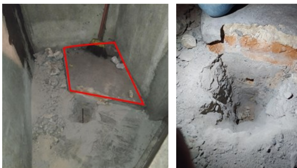
Imagens 01 e 02 - Fotografias da perfuração 01. Escavou-se a uma profundidade de 1,30m a partir do nível do piso do Salão dos Arcos. Destaque em vermelho para parte do bloco de fundação estrutural do TMSP.
