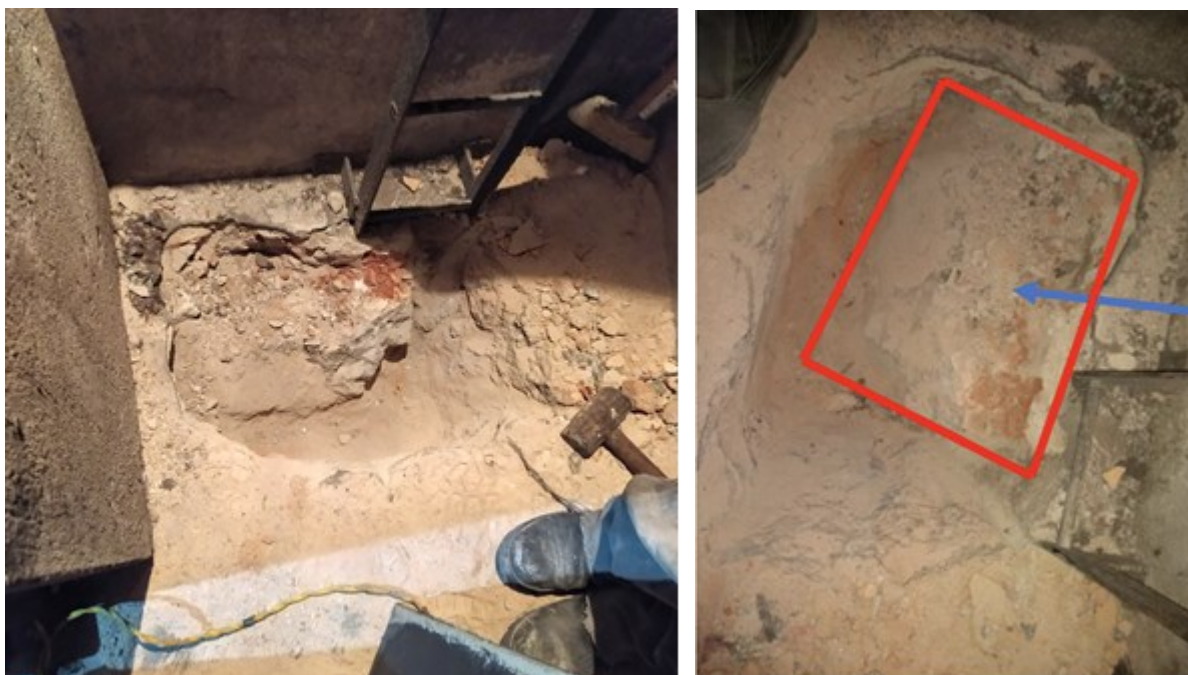
Imagens 03 e 04 - Perfuração 02. Foi encontrada parte das fundações estruturais do TMSP neste ponto de prospecção - Destaque em vermelho.
