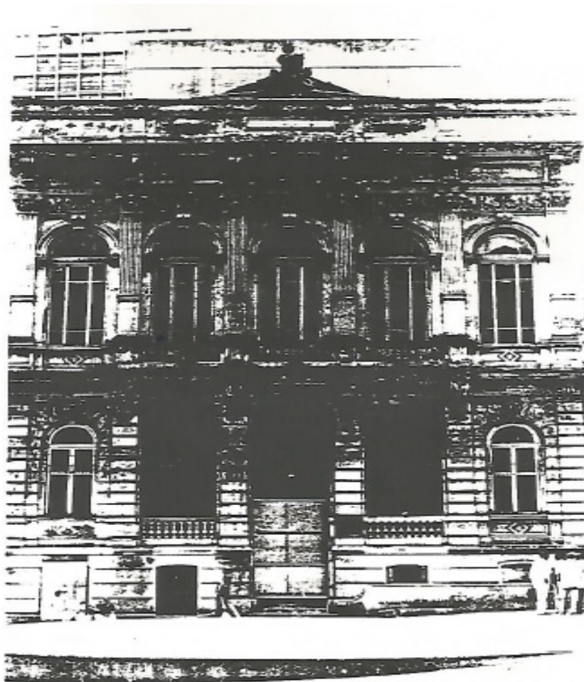
Conservatório Dramático Musical de São Paulo, quase em ruínas, e o inútil palco de granito à sua frente.
